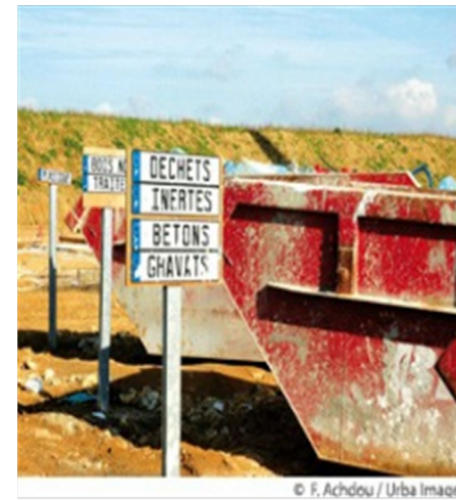
Photographie 3 : Exemple de benne pour un chantier (Source : www.ademe.fr)
