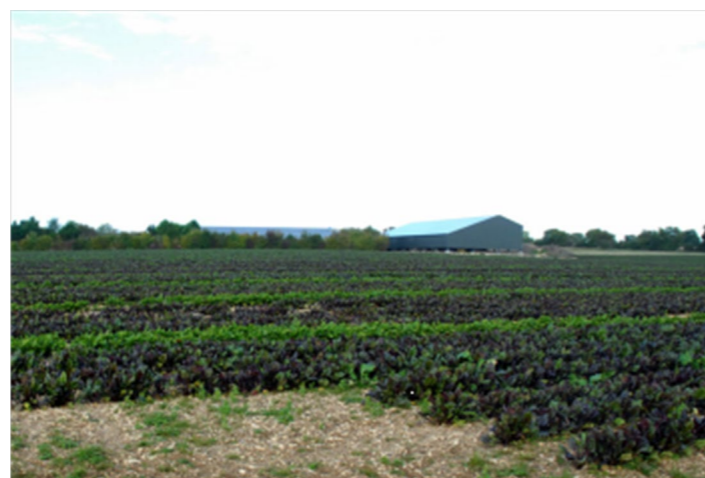
Figure 80 : Panneaux photovoltaïques sur bâti agricole
