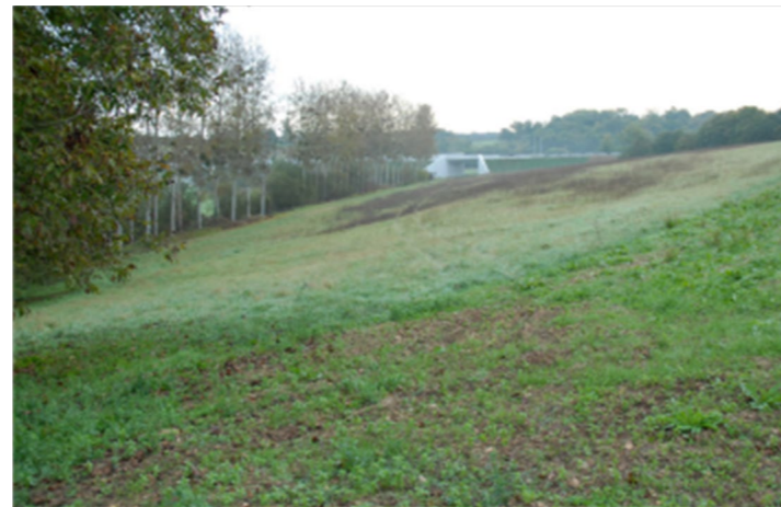
Figure 88 : Chantier de la LGV sur la Péruse à Montjean
