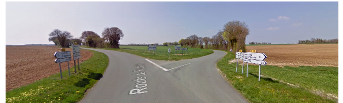
Figure 59: Croisement entre la RD 52 et la RD 52E
